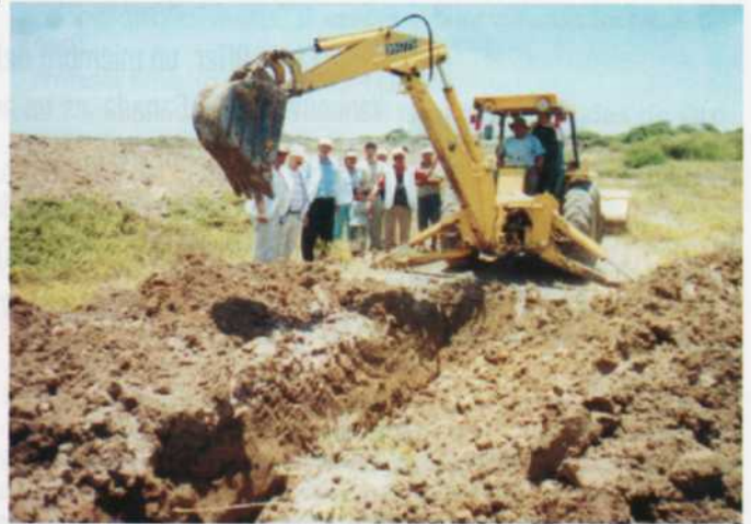
Abriendo canales de regadío en el fundo "Philadelfia".
