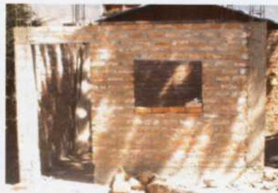
Construcción de cocina en un CEI (355)
